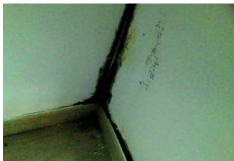
Fig. 3.1 Nei ponti termici, cioè nelle zone più fredde dell'edificio, facilmente si forma la condensa che a sua volta diventa la causa di sviluppo delle muffe.
