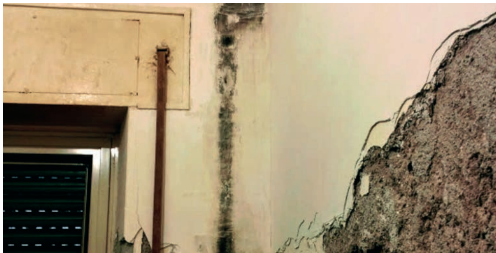
Fig. 3.2 Interessante situazione dove la formazione di muffa è avvenuta in corrispondenza di una tubazione di acqua fredda. Praticamente, l'abbassamento di temperatura localizzato dovuto al flusso di acqua fredda, ha causato la condensa in superficie, sulla quale ha poi attecchito la muffa solo in prossimità dei tubi.
