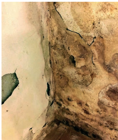
Fig. 2.2 Oltre a rendere possibile la formazione delle muffe, l'umidità è la principale causa di danno e degrado degli edifici.
