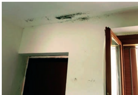
Fig. 2.7 Affidare alla sola apertura delle finestre la funzione del ricambio d'aria può non essere sufficiente. In questo caso l'edificio si affaccia direttamente sulla strada e l'apertura della finestra comporta oltre all'ingresso dell'aria anche quello del rumore, perciò viene mantenuta aperta per intervalli molto brevi e poco frequenti che si sono dimostrati insufficienti.
