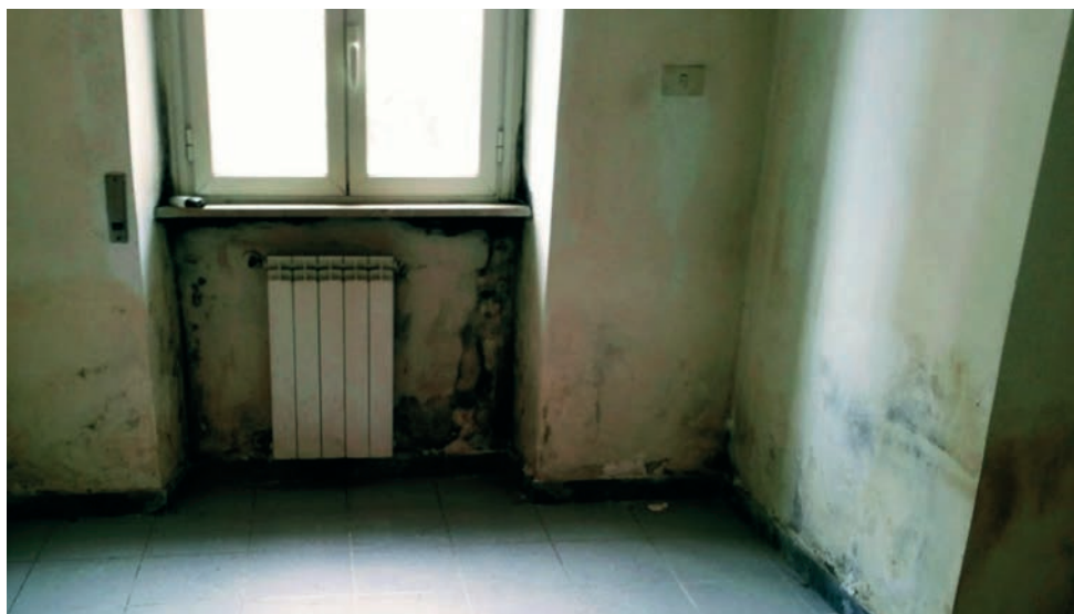
Fig. 2.1 Una casa pesantemente contaminata dalle muffe, ha bisogno di tempi piuttosto lunghi per la bonifica e di somme ingenti per la sua riqualificazione.
