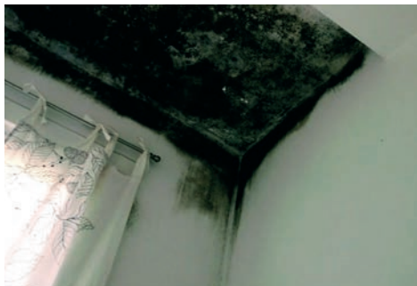
Fig. 2.4 In molti casi le formazioni di muffa sono dovute alla combinazione di fattori derivanti dall'edificio e dalle modalità con cui questo viene utilizzato e gestito. Nella foto si osserva una massiccia presenza di muffe nere, probabilmente Aspergillus dovute alla bassa temperatura delle superfici che sono la causa di condense, unite a una scarsa manutenzione.
